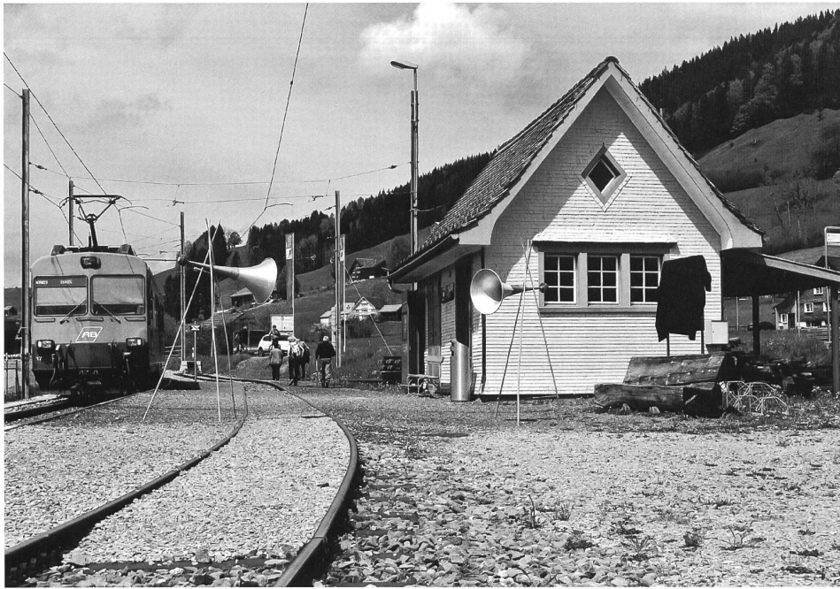
Die Bahnstation Rietli (Bild: Markus Wicki)
