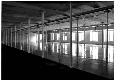
Die Säulenhalle der Flumserei. (Bild: pd)
