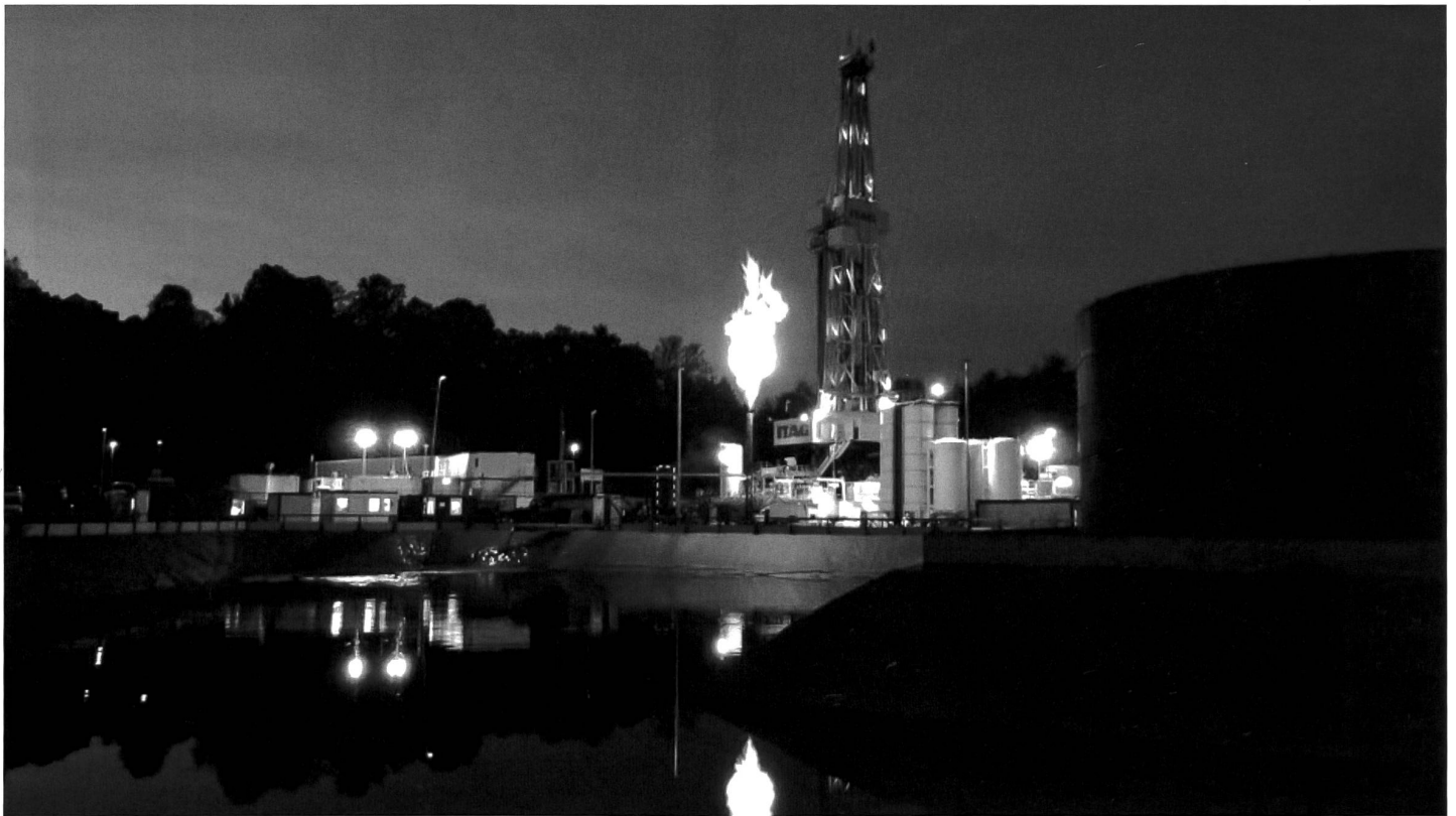
Running Gag: die missglückte Geothermie-Bohrung, 2013 im Sittertal. (Bild: St.Galler Stadtwerke)
