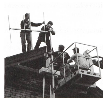
Eigenhändige Montage der Sendeanlage. (Bilder: Rafael Zeier)
