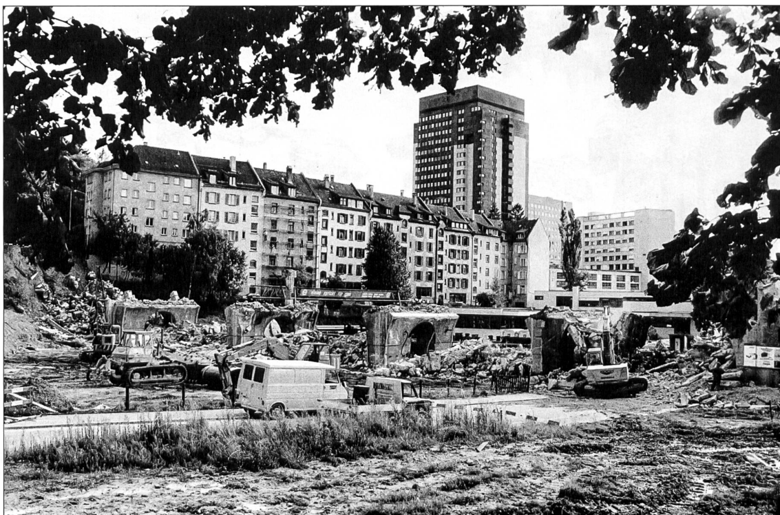
Die alte Splügenbrücke in St.Fiden wird 1980 abgerissen. Rund 200 Meter weiter östlich entstand 1983 die heutige Splügenbrücke.
