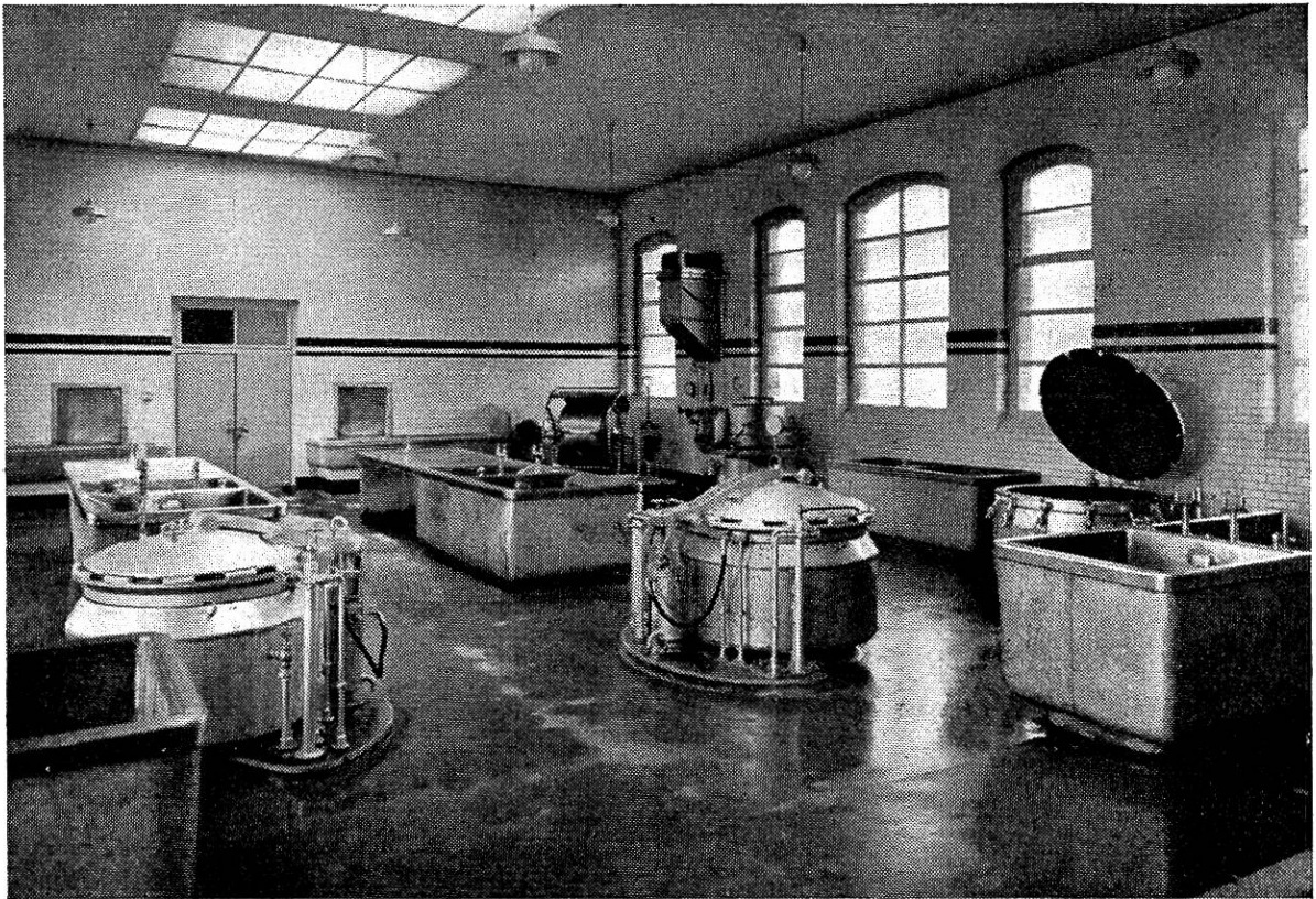
Großkuchtlei, gegen den Düngerentleerungsraum gesehen.
