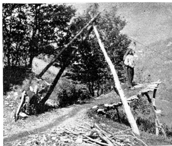
Fig. 30 Obere Station einer einfachen Drahtriese (s. S. 11)
