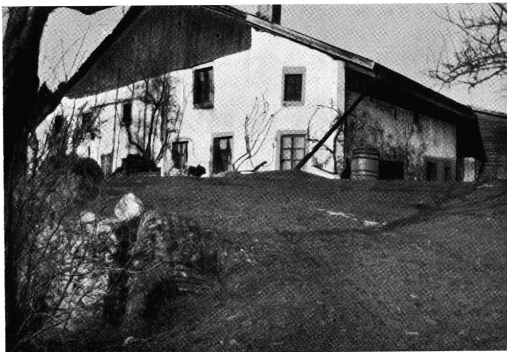
Fig. 1: Ferme de Clermont (bâtie en 1686) «PAIX SOIT ICY»
