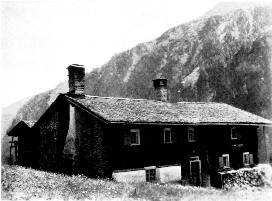
Kaminführung ausserhalb des Hauses
