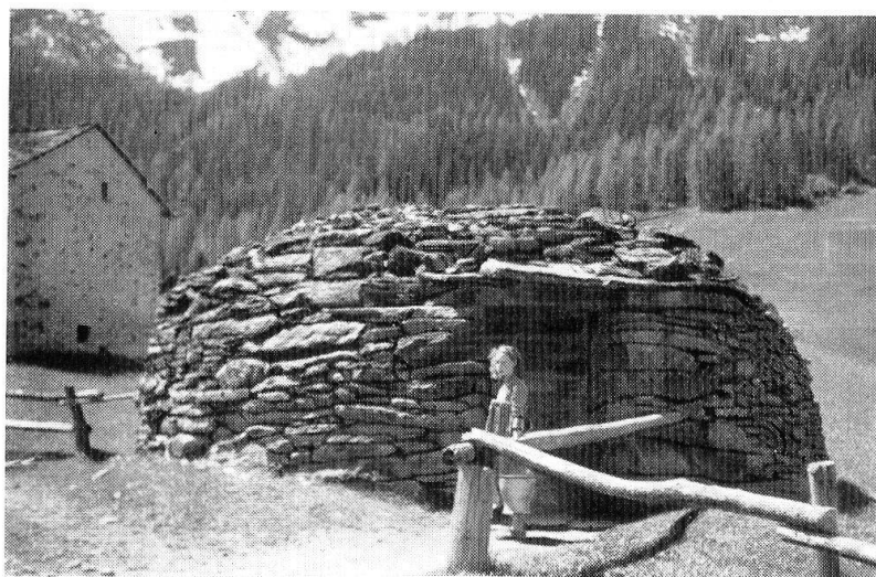
Fig. 30. Maggengo di Selva. cròt , che serve da cantina del latte.
