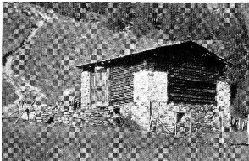
Fig. 28 – Alpe pozòl presso La Ròsa. Fienile e stalla con zoccolo e pilastri di pietra e con la parte superiore a cruséra .
