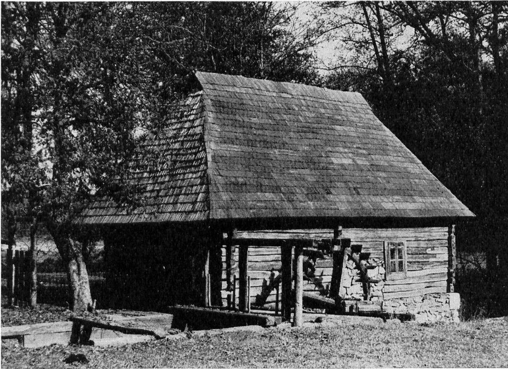
Fig. 2. Mühle mit senkrechtstehendem, unterschlächtigen Wasserrad aus Dăbîca, Region Hunedoara.
