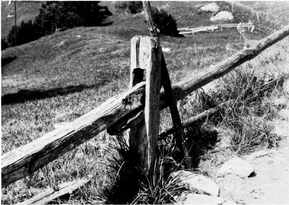
Abb. 1. Pfahlzaun, der ohne Nägel erstellt wurde.
