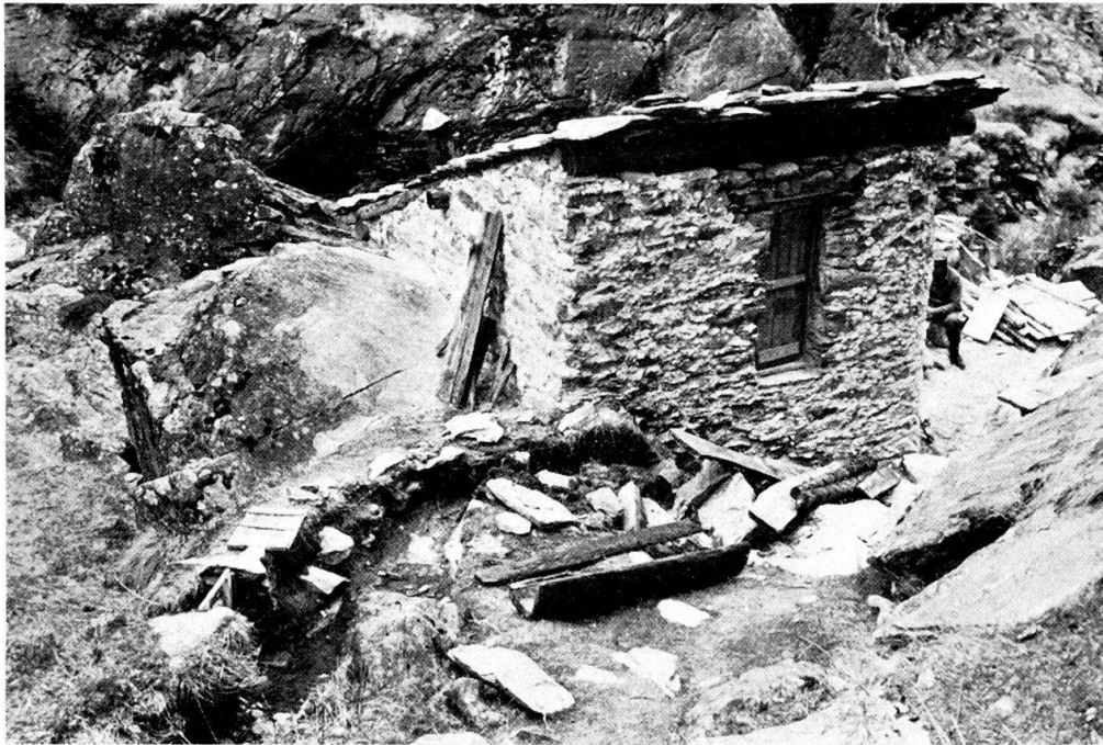
Abb. 1. Die Werkstatt-Hütte des Lavezdrehers Migola im Valbrutta, Blick talwärts. Vom linken Bildrand führt der Wasserkanal zur Hütte, die links von diesem, an einen grossen Felsklotz angelehnt, angebaut ist.
