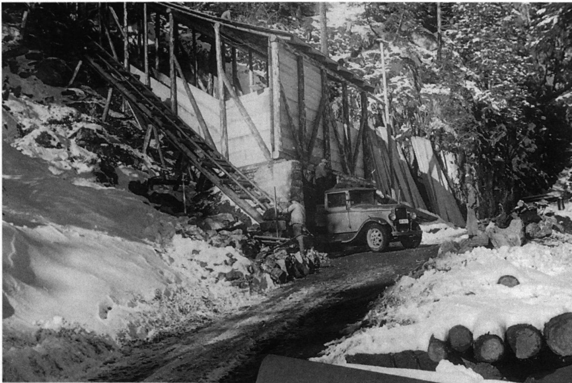
Kohlensilos mit Rollwagenaufzug
