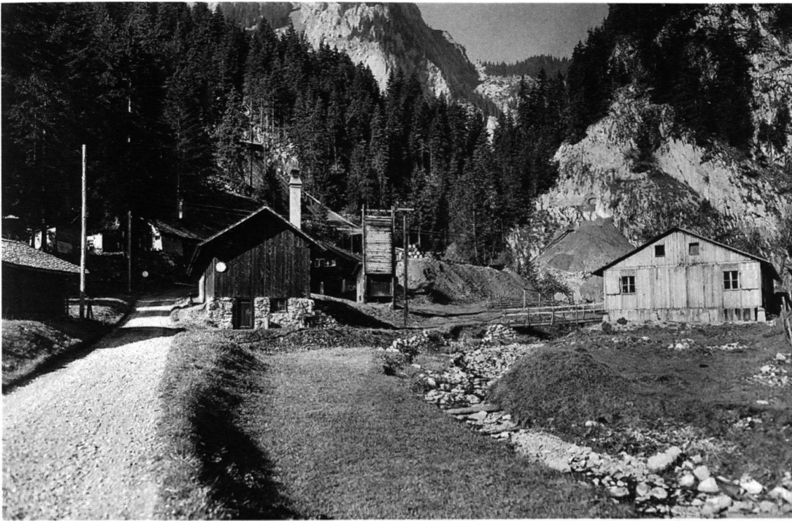
Gesamtansicht mit Bade- und Schlafbaracken
