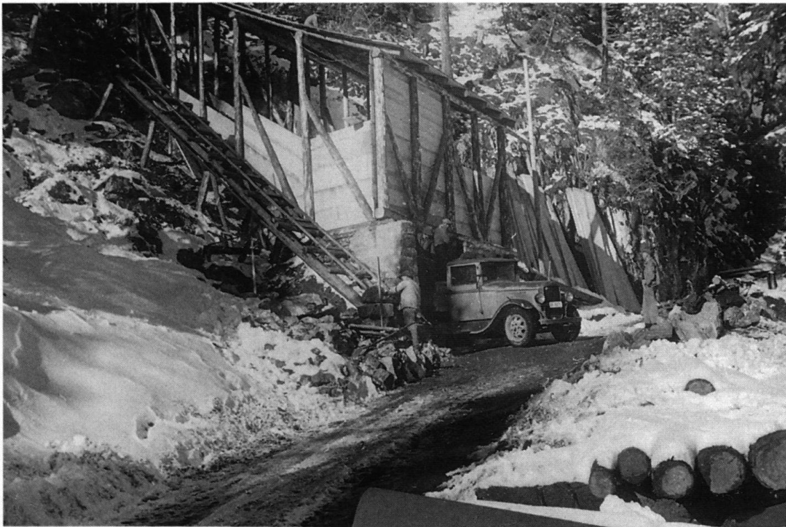
Kohlensilos mit Rollwagenaufzug
