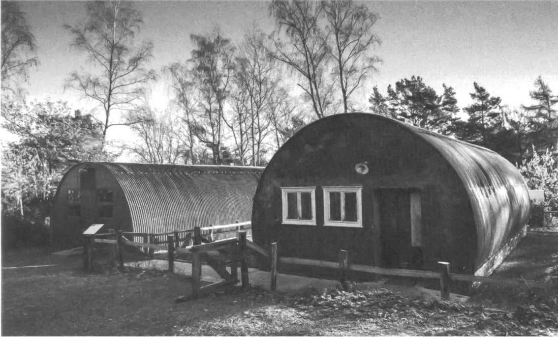
Abb. 4: Nissenhütten, im LVR-Freilichtmuseum Kommern.
