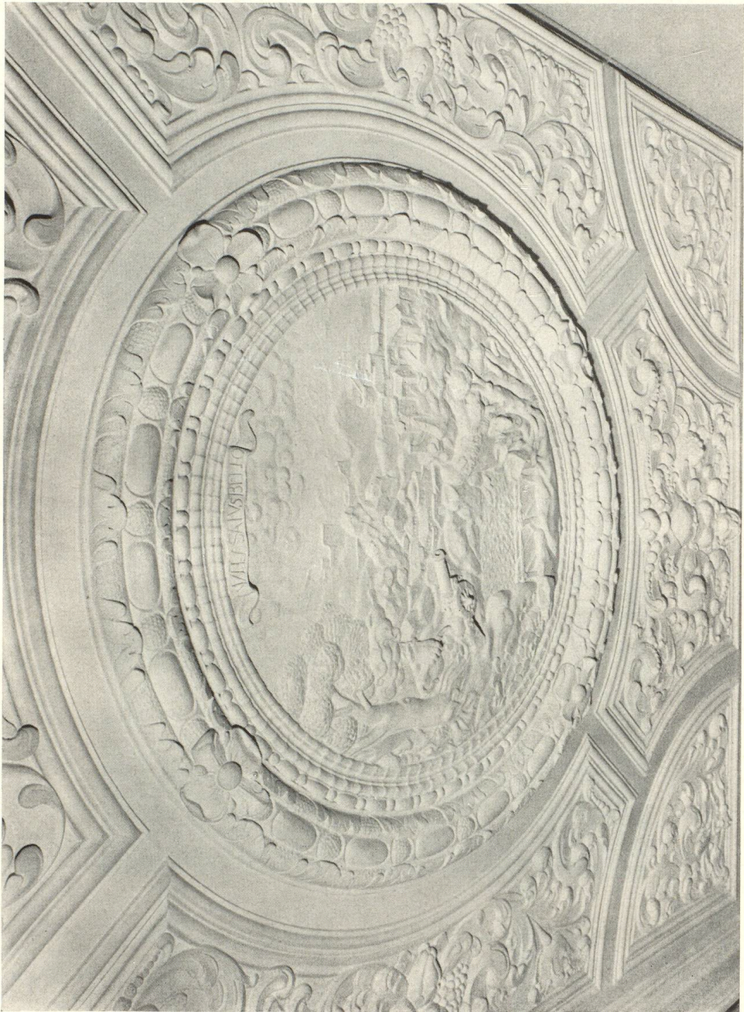
Haus zur Fels, Stuckdecke im Saale des II. Stockes
