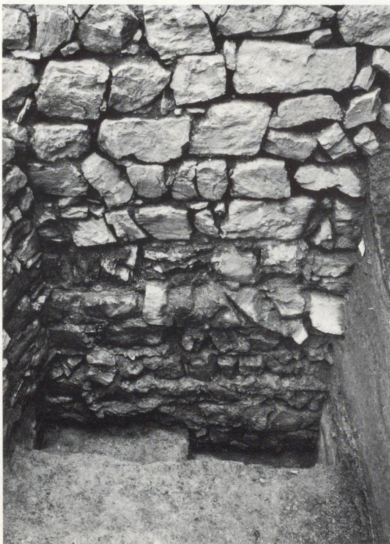
Abb. 4 Der Fundamentbereich der Stadtmauer des mittleren 13. Jahrhunderts.
