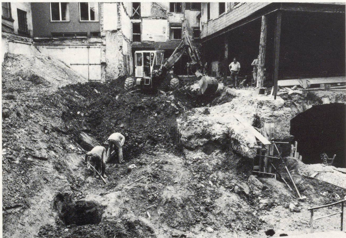
Abb. 3 Im Wettlauf mit der Baggerschaufel werden im hausnahen Bereich Gerbergruben freigelegt und dokumentiert.
