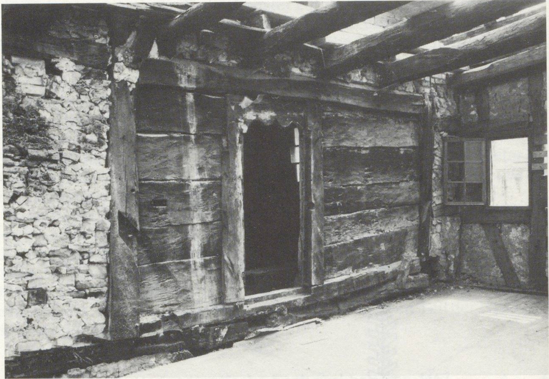
Abb. 4 Westwand der spätgotischen Stube von 1467 mit Kielbogentüre vom Turm aus gesehen.
