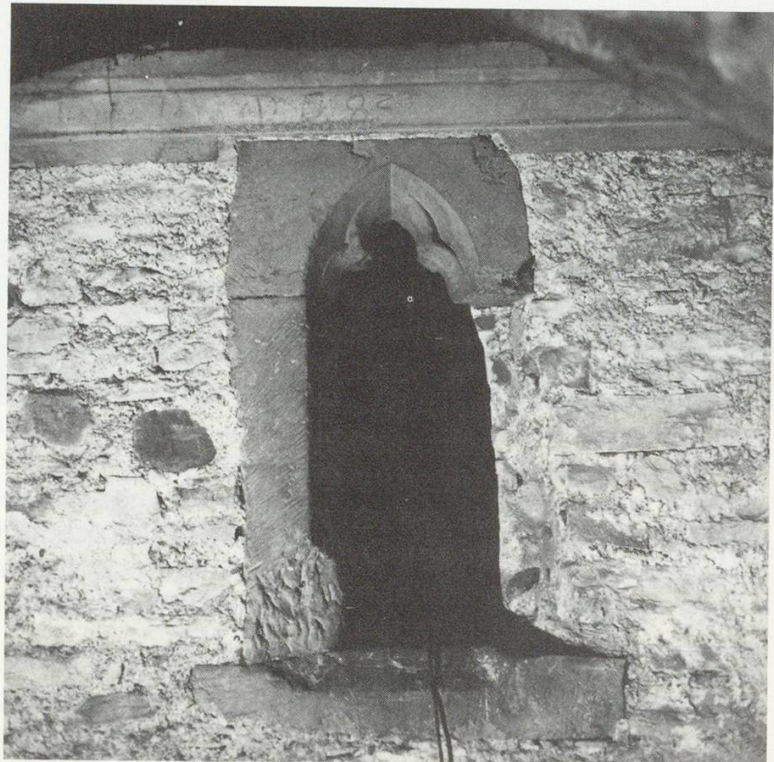
Abb. 29 Im Obergeschoss über der Sakristei zeigt sich die ehemalige Südfassade der vierten Kirche mit Masswerkfenster und Dachgesims. Sie ist 1515/17 mit dem Anbau der äusseren Seitenschiffe in den Dachraum gelangt.
