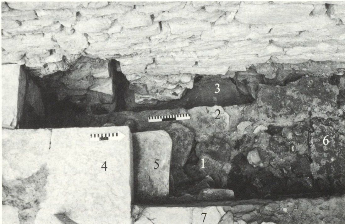
Abb. 8 Detail der südlichen Choransätze von Bau I und II, die südlich des heutigen Chores zutage traten: 1 Chorsüdwand I, 2 Steinbank I, 3 Mörtelgussboden I; 4 Triumphbogenpfeiler II, 5 Stufe II, 6 Mörtelboden II, 7 Sandsteinplattenboden III.
