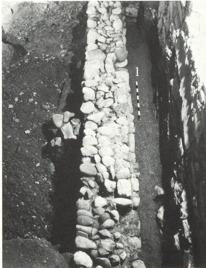
Abb. 37 Südwand des Profanbaus M3 aus dem 12./13. Jh. mit der im Mauerwerk ausgesparten Feuerstelle (1). Rechts das Fundament der Kirchen- nordwand von 1466/72.
