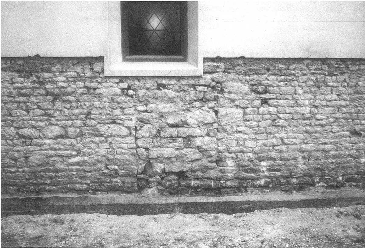
Abb. 2: Nordseitiges Mauerwerk des Kirchenschiffs aus dem 11. Jahrhundert im Bereich des ehemaligen Eingangsportals. Es besteht aus lagerhaft verlegten Handquadern aus Kalk, auf Sicht gemauert mit Resten von Fugenstrich.
