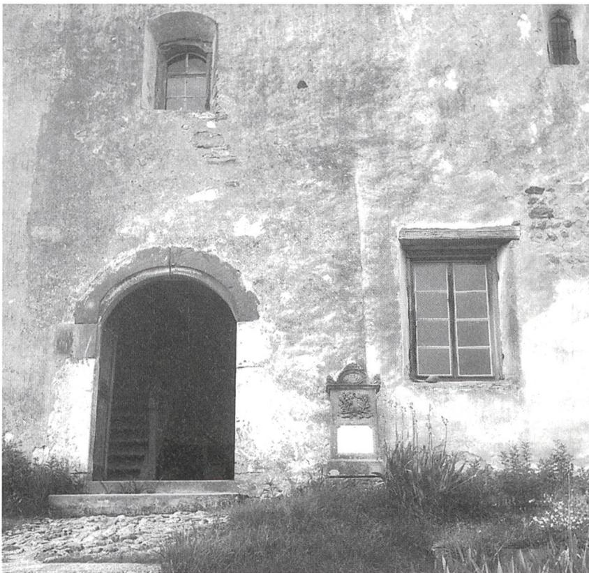
*Abb. 44: Südeingang der Kirche aus Sand- und Kalkstein von 1688, 1953 ersetzt (vgl. Abb. 41).*
