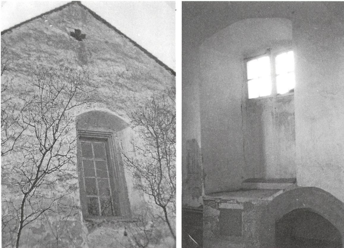
Abb. 30: Chorostwand mit spätgotischem Fenster von 1487/88, darüber romanischer Kreuzschlitz, um 1150, aufgenommen vor der Renovation von 1953 (vgl. Abb. 8).
