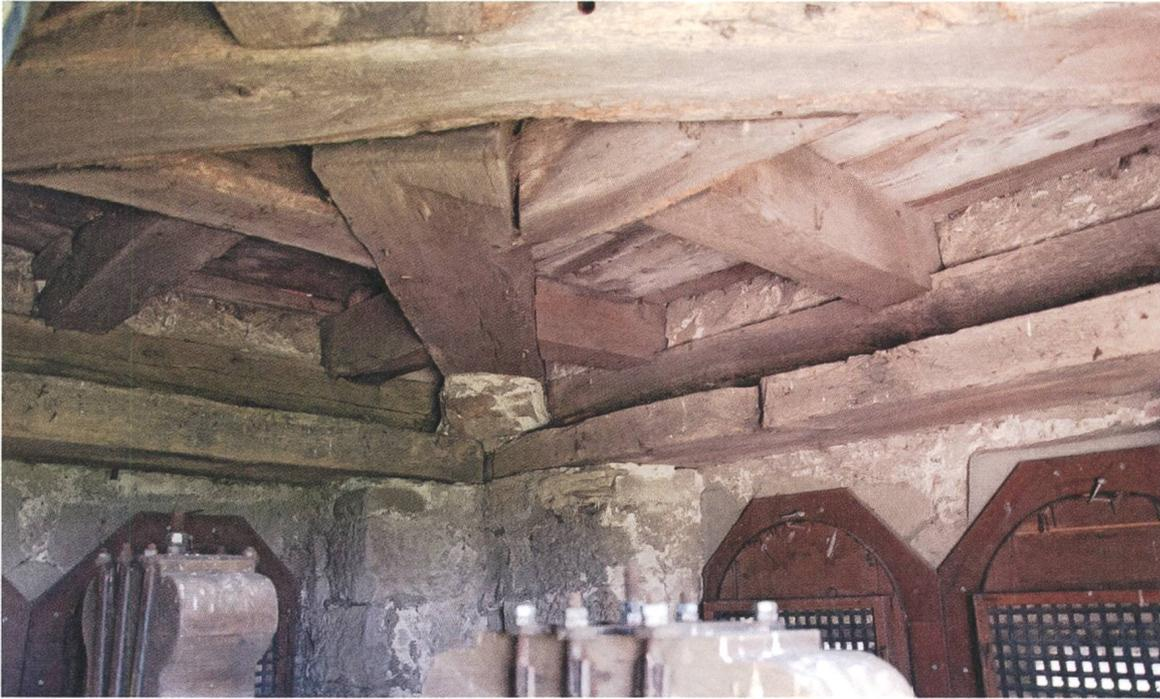
*Abb. 49: Im Glockengeschoss des Turms von 1702 tragen die kräftigen Eichenstürze auf den Kalkbruchsteinecken das Eichengebälk des Spitzhelms.*
