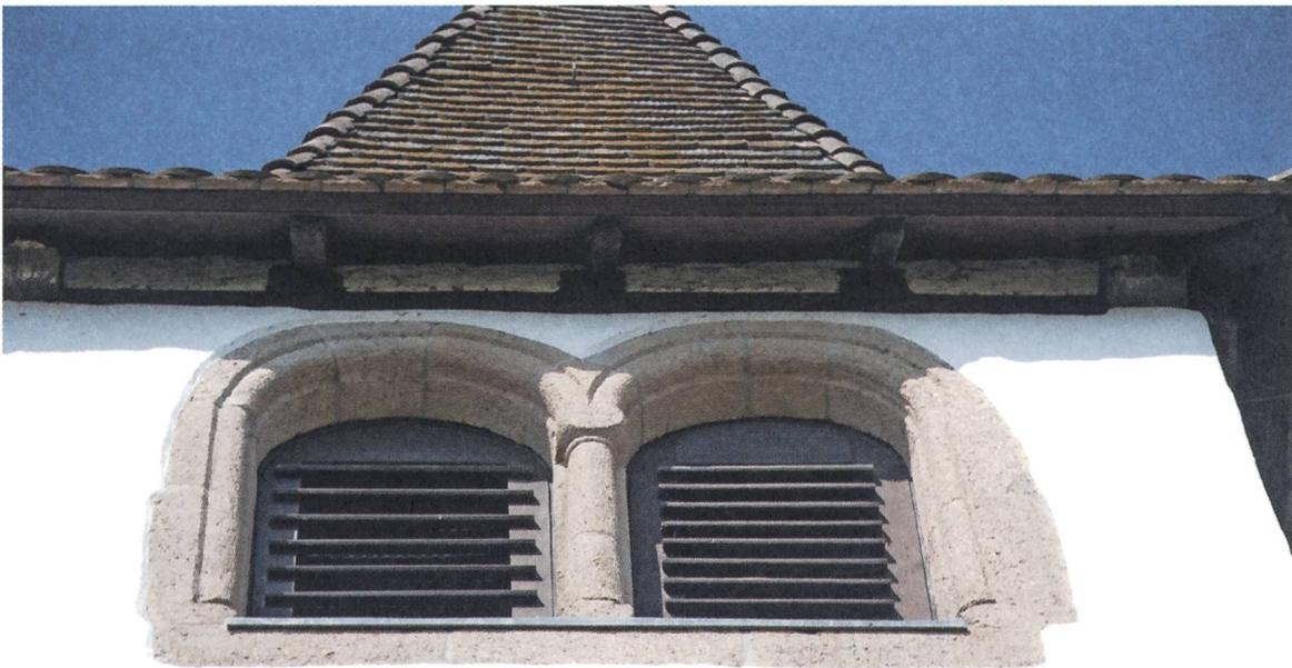
*Abb. 22: Schallöffnung aus Randengrobkalk aus dem späten 13. Jahrhundert, wiederverwendet im Glockengeschoss (Südfassade) des Turms von 1702.*
