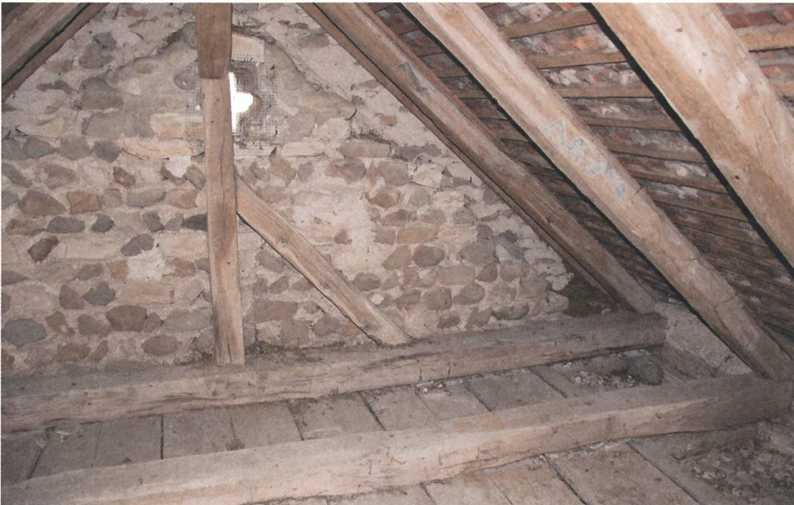
*Abb. 23: Handgespaltene Bohlenbretter von 1273 im Chordachstuhl von 1738.*
