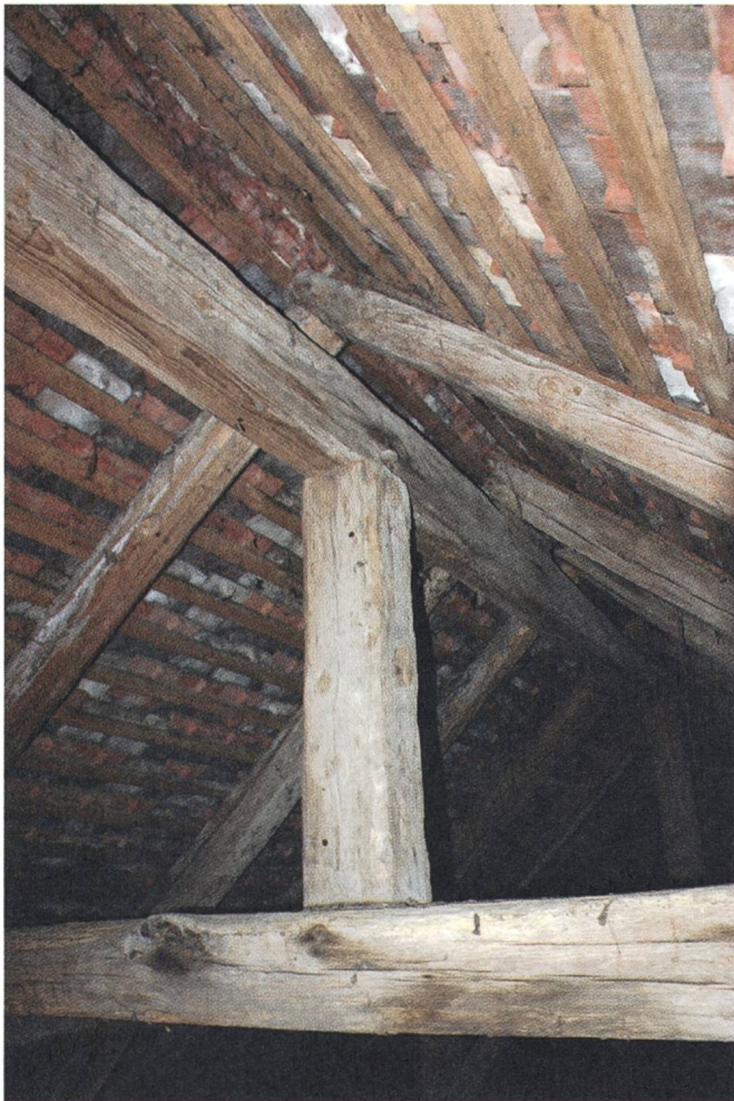
Abb. 9: Zu kurzer Stuhlständer im heutigen Dachspitz.
