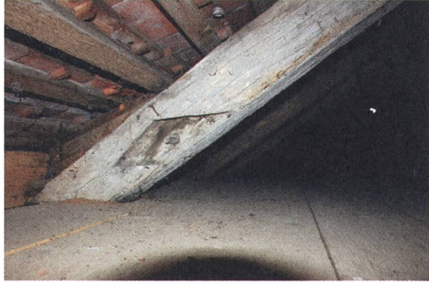
Abb. 7: Zapfenloch mit vernageltem Zapfenrest und benachbartes Holznagelloch.
