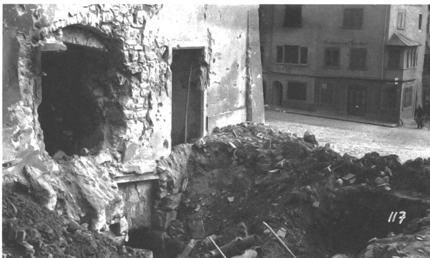
6 Bombentrichter an der Beckenstube. Stadtarchiv Schaffhausen.
