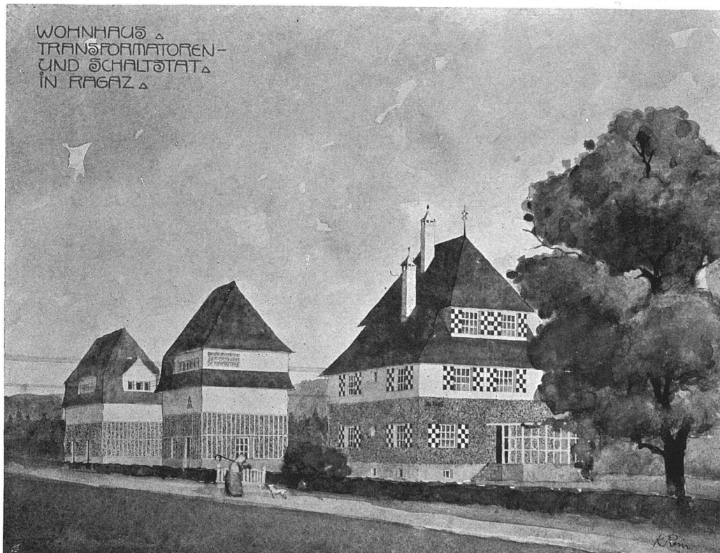
Wärterwohnhaus, Transformatoren- und Schaltstation in Ragaz
