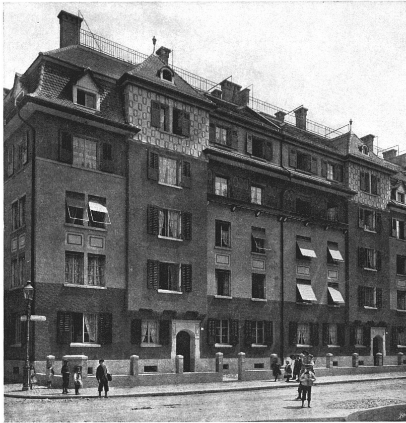
Städtische Wohnhäuser im Industriequartier Teil der Fassade an der Heinrichstraße von Hausblock II
