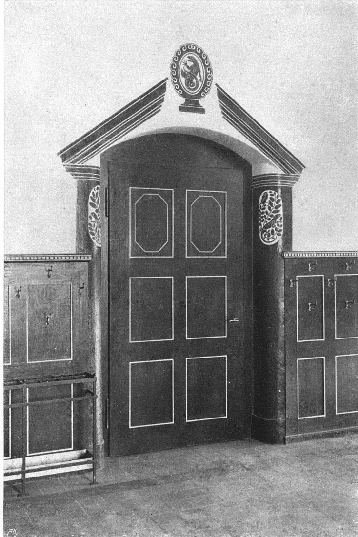
Schulzimmer-Türe im Gang des ersten Stockes, Holzwerk rot gestrichen in gewellter Pinselführung, durch Linien und Ornamente in gebrochenem Weiß belebt. — Fußflächen raub abgerieben. — Architektur-Umrahmung rot aufgemalt
