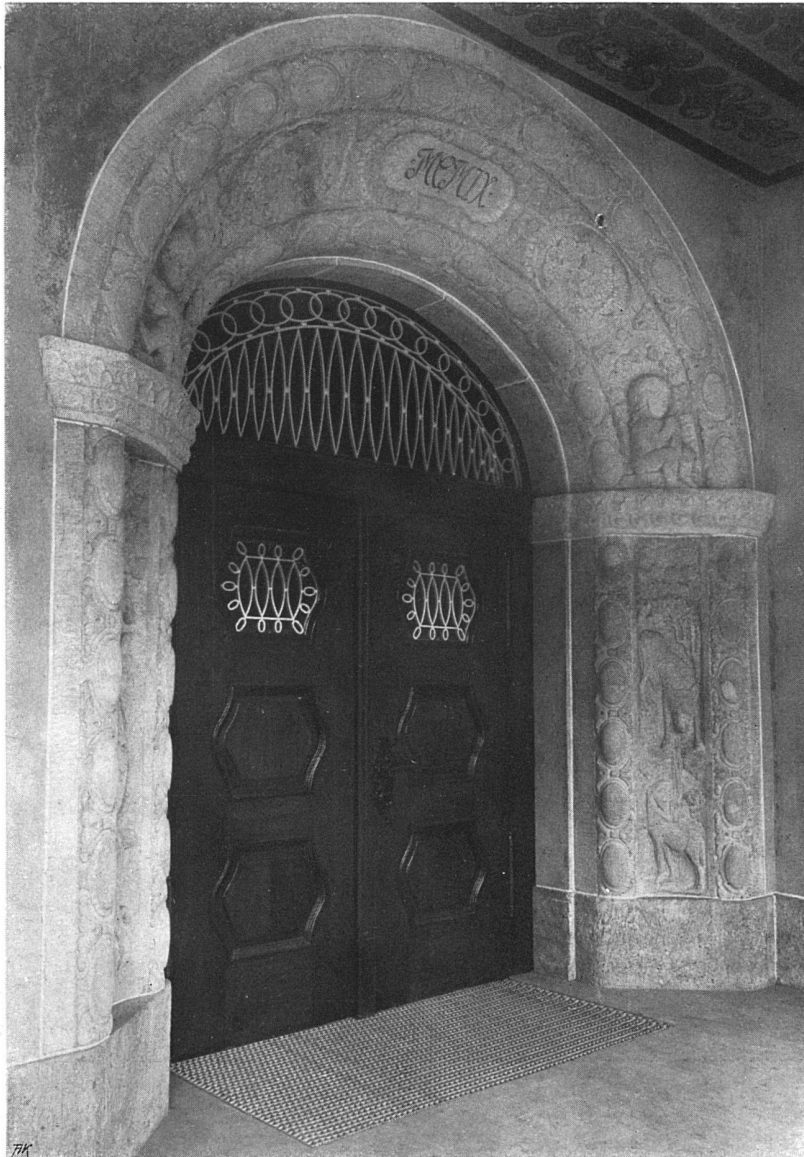
Bildhauerarbeiten von Ad. Meyer, Zürich, ausgeführt in überarbeitetem Kunststein. — Holztüre in Natureichen. — Gitter von Kunstschlosser Fritz Weber, Zug, weiß gestrichen. — Holzdecke bemalt in Blaugrau mit Gelb
