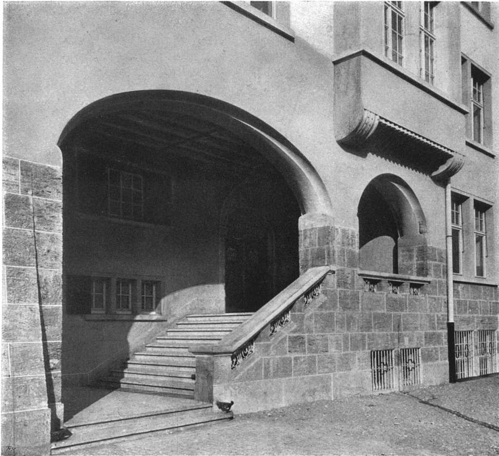
Das Neustadt-Schulhaus in Zug. — Neufere Eingangshalle mit Treppenaufgang. — Sichtbares Quadermauerwerk in Luff aus „Surava“. — Architekten B. S. A. Keiser & Bracher, Zug.
