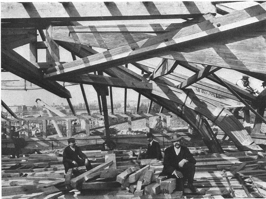
Blick in den Dachstuhl des Hotels Beauregard in Lausanne. — Aus- führung durch Ed. Bugnion, Entreprise de charpentes, Lausanne.
