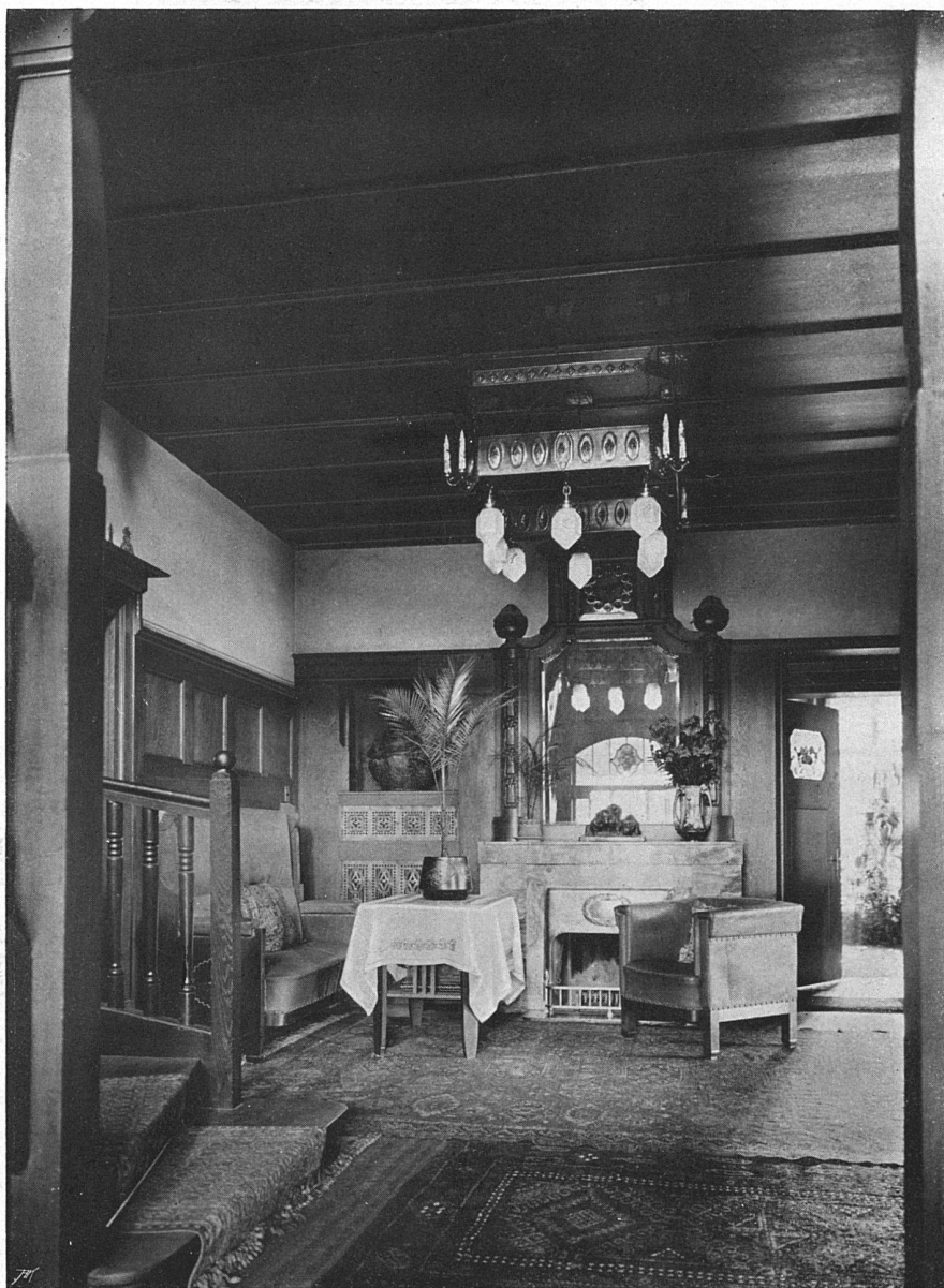
Blick in die Halle. — Gefäße, Decke und Möbel in grün gebeiztem Eichenholz. — Bezug der Eigmöbel Natur-Schweinsleder. — Leuchter und Heizkörperverkleidung in Alt-Kupfer. — Ziffer- blatt der Uhr über dem Spiegel in Alt-Messing. — Ausführung von W. Dollinger, Basel Photographien von Kling-Senny, Basel
