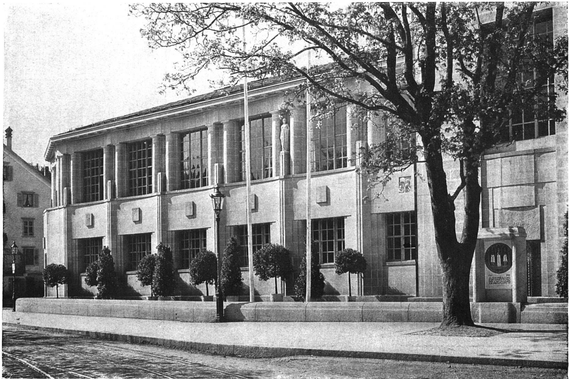
Ansicht des Flügelbaus gegen den Heimplatz Photographien von Ph. & C. Vint, Zürich
