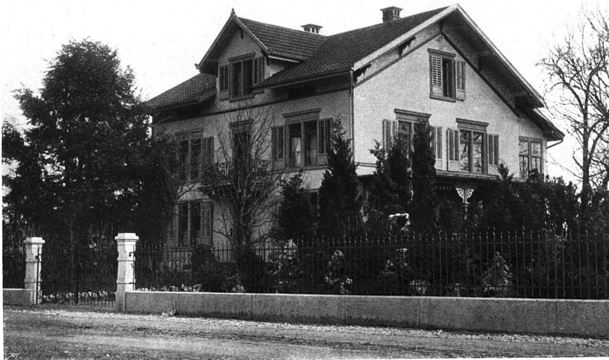
Die Straenfassade vor dem Umbau
