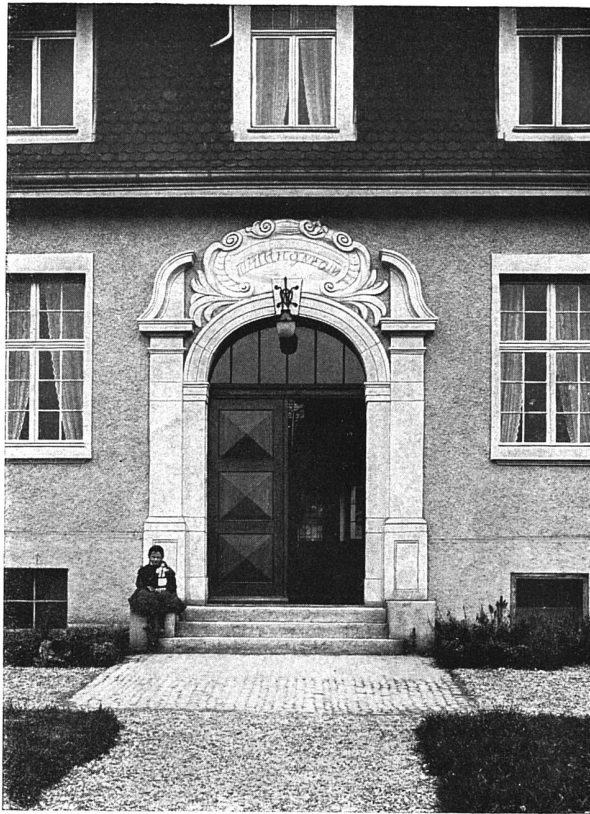
Hauptportal an der Nord-Ost-Fassade
