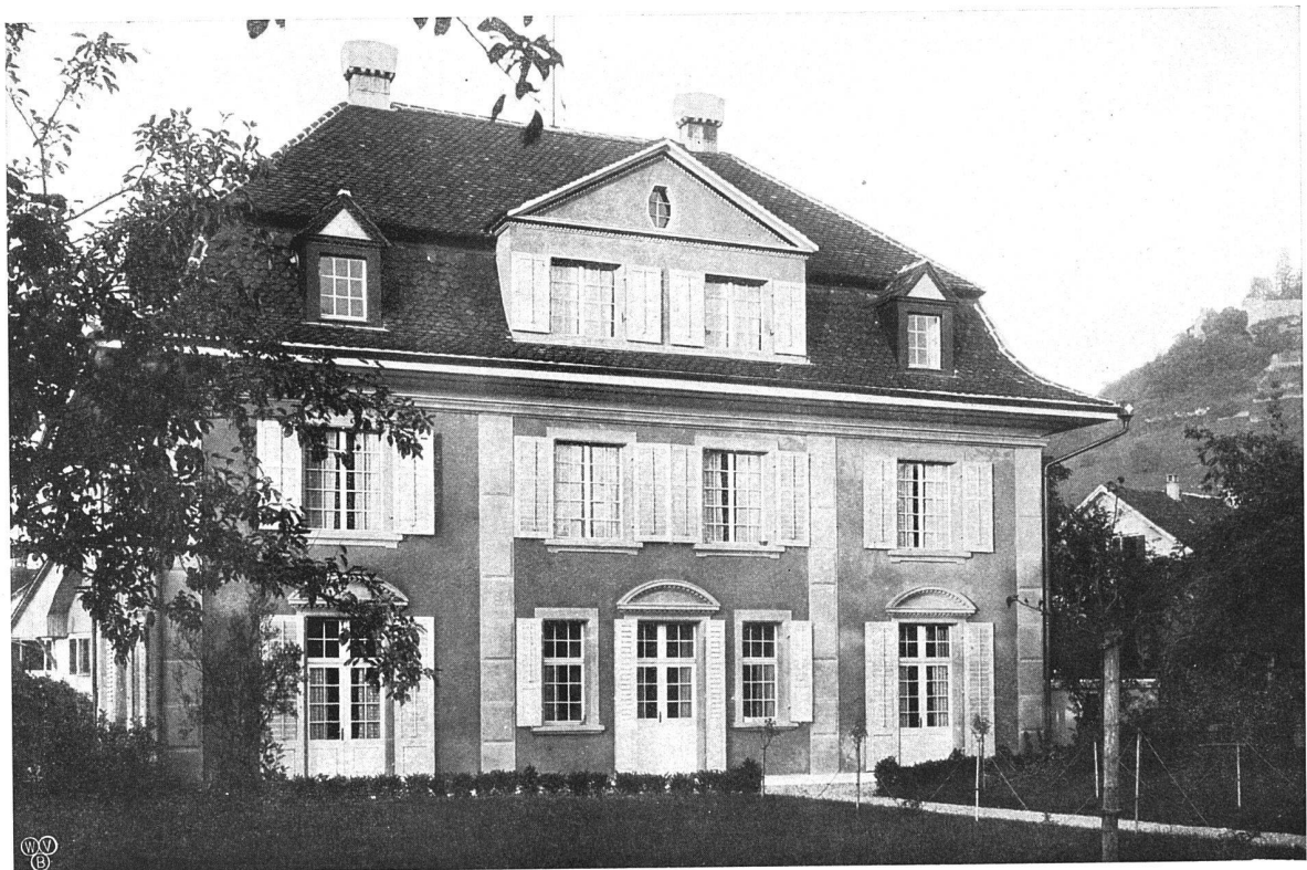
Wohnhaus Otto Bertschinger in Lenzburg
