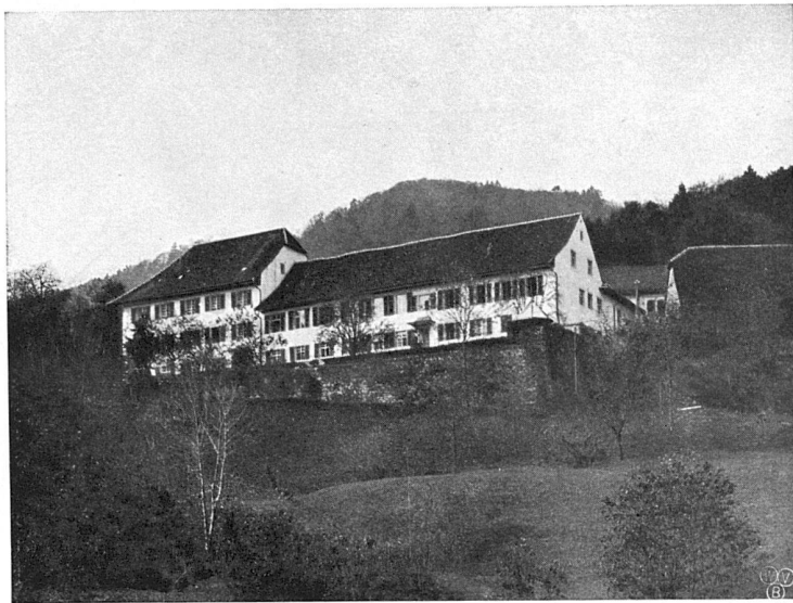
Vordergebäude im alten Zustand, renoviert
