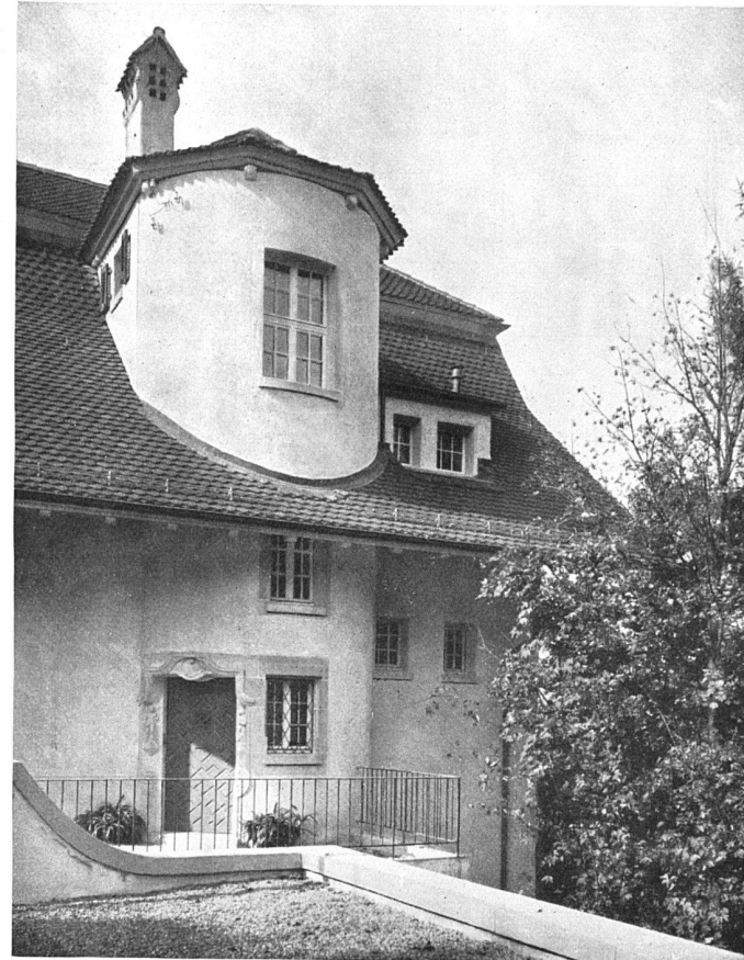
Wohnhaus Kollerweg 11 Nordostfassade :: ::
