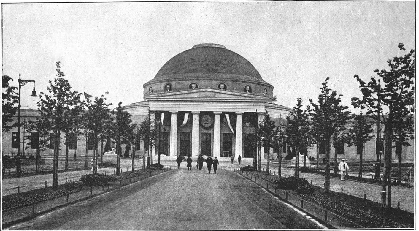
Baufach-Ausstellung in Leipzig :: Betonhalle ::
