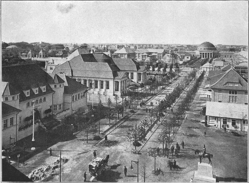
Baufach-Ausstellung in Leipzig :: Gesamtansicht ::
