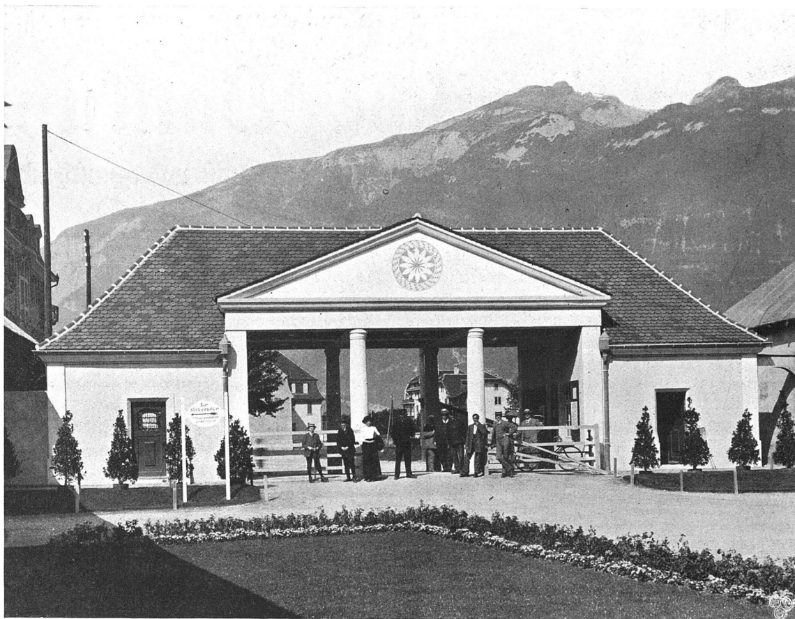
Gewerbeausstellung Chur :: Eingangsgebäude ::
