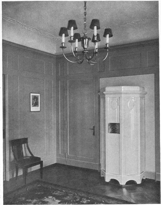
Aus dem kleinen Wohnzimmer Graugelbtes Wandtäfel, weiße Stuck-Decke, Kachelverkleidung des Heiz- körpers
