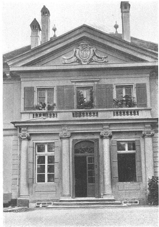
Mittelpartie des Hauptgebäudes.
