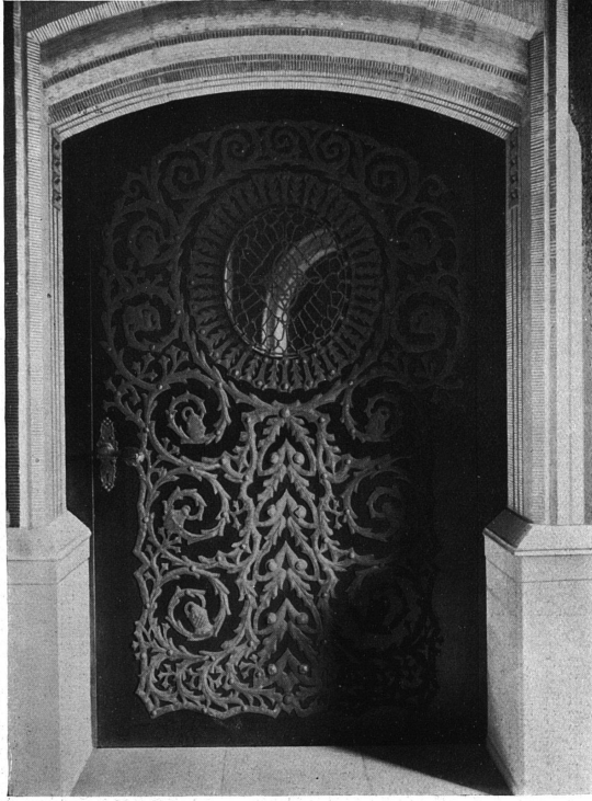
Die Türe des Hauptportals. Türbeschlag ausgeführt von Peter Josef Koch, Köln a. Rh. Der Wiederaufbau des Schlosses Hülchrath bei Düsseldorf. — Architekt Otto Zollinger, Zürich 5, Zeltweg.
