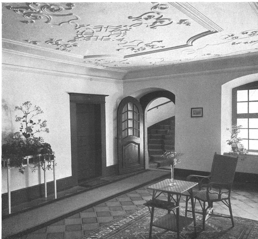
Das Vestibül im ersten Stock des alten Hauses mit der einzigen noch erhaltenen Stuckdecke. Der Umbau der Kuranstalt «Brestenberg» am Hallwilersee. — Architekt Eugen Probst, Zürich.
