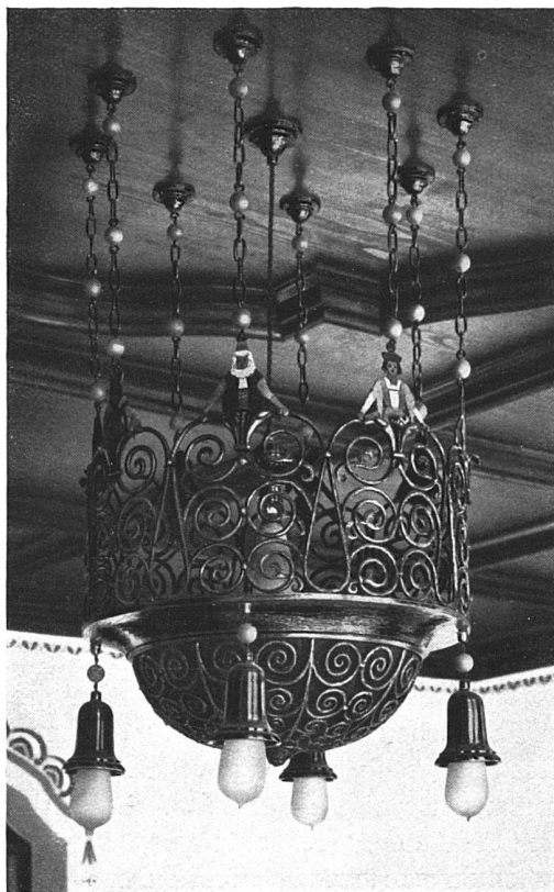
Beleuchtungskörper in der Halle in Schmiedeeisen und Messing mit bunt bemalten Figuren und blau gestrichenen Holzkugeln. Ausgeführt durch Baumann, Kölliker & Co., Zürich.
