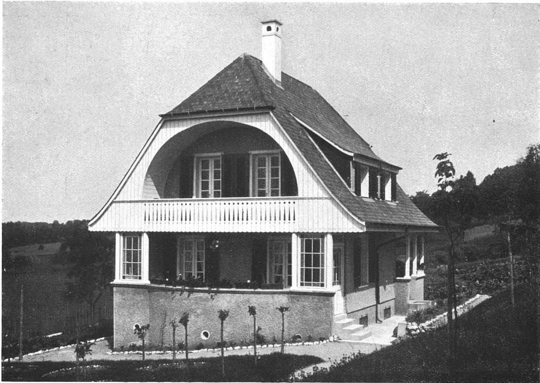
Einfamilienhaus in Muri bei Bern.
