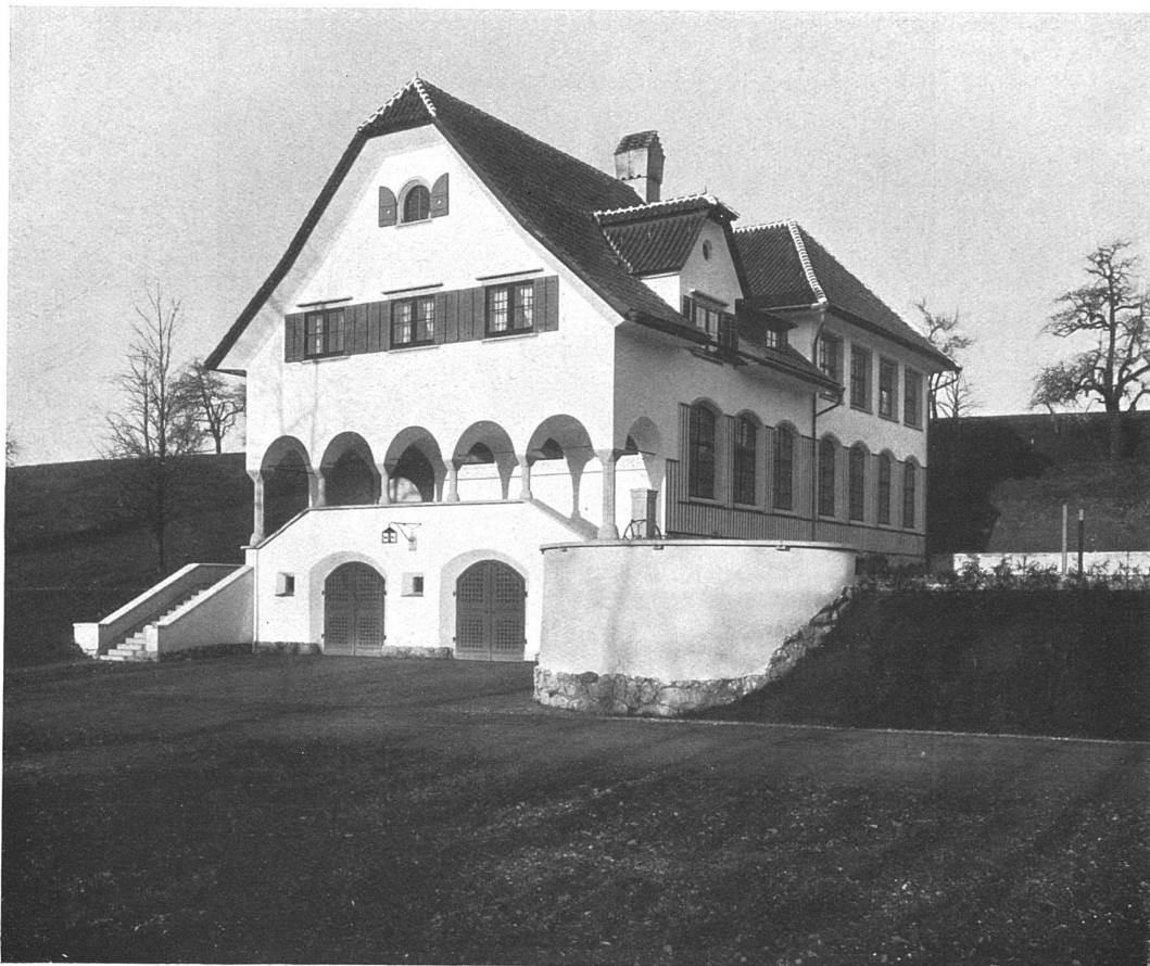
Das Schulhaus zu Rifferswil am Albis (Kt. Zürich). Ansicht von Süden. Architekt F. B. Frisch, Zürich. Aufnahme von Ph. & E. Link, Zürich. — Grundrisse vergl. S. 152.
