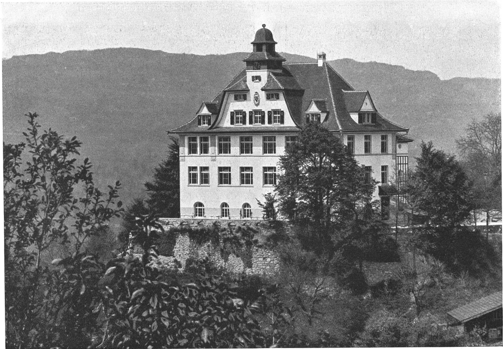
Das Burgschulhaus zu Büron (Kt. Luzern). — Architekten Meili-Wapf und F. Amberg, Luzern. Aufnahme von J. Meiner, Zürich.
