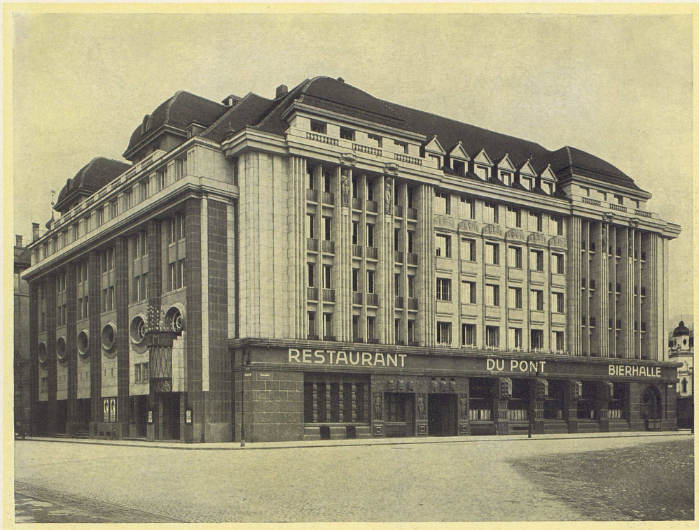
Das Haus Du Pont zu Zürich. — Architekten Haller & Schindler, Zürich. Die Seitenfassade in der Waisenhausgasse ist in schwarzem, rötlichem und gelblich hellem Kunststein, die Hauptfassade am Beatenplatz über einem Sockel in schwarzem in gelblich hellem Kunststein ausgeführt. Die Figuren in den Nischen der Hauptfassade von Bildhauer Gysler, Zürich, die Bekrönungen über den Fenstern von Bildhauer A. Meyer, Zollikon.
