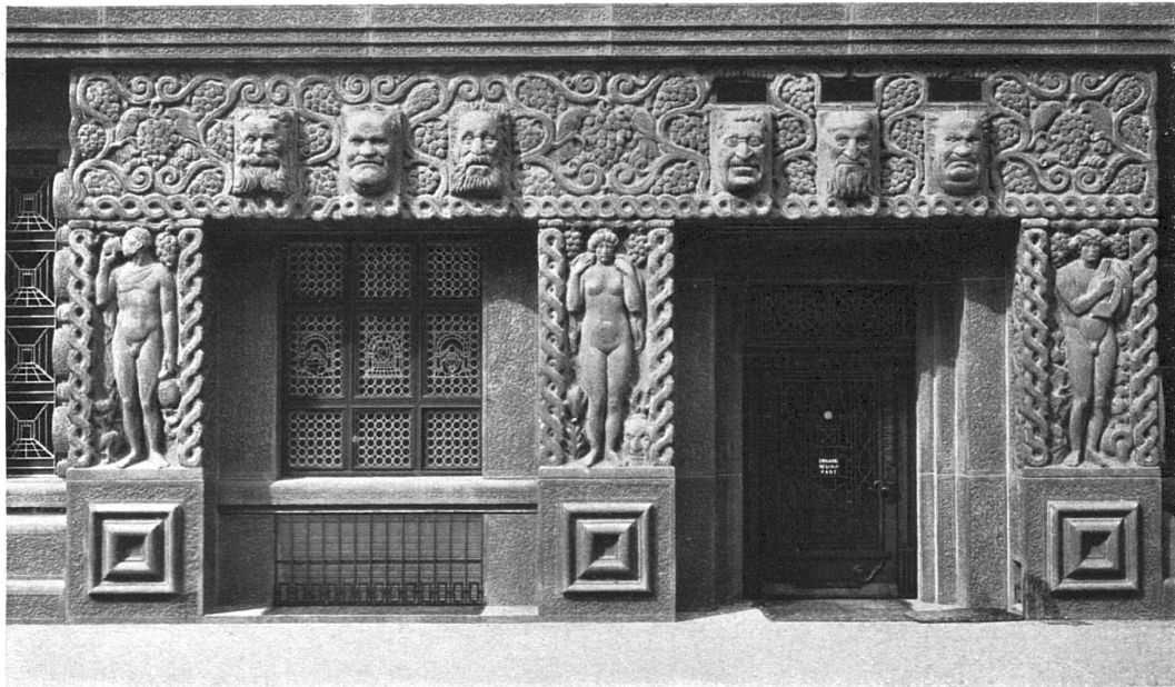
Das Haus Du Pont zu Zürich. — Der Eingang am Beatenplatz; in schwarzem Kunststein ausgeführt. Architekten Haller & Schindler, Zürich. — Bildhauer A. Meyer, Zollikon.
