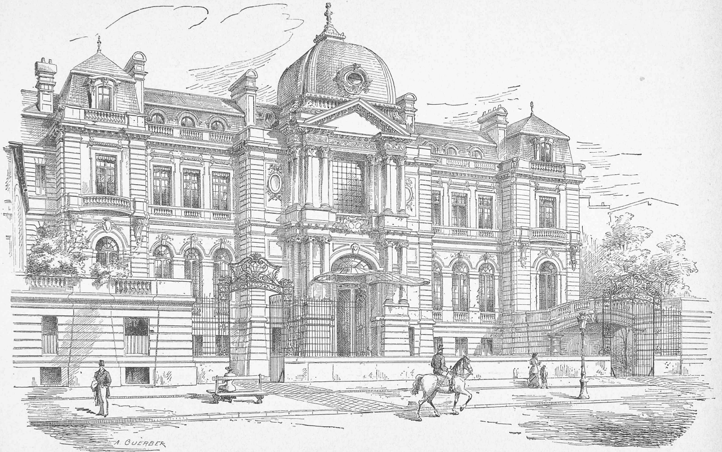
Hôtel de M. le Comte de Potocki, Avenue de Friedland. — Façade.
