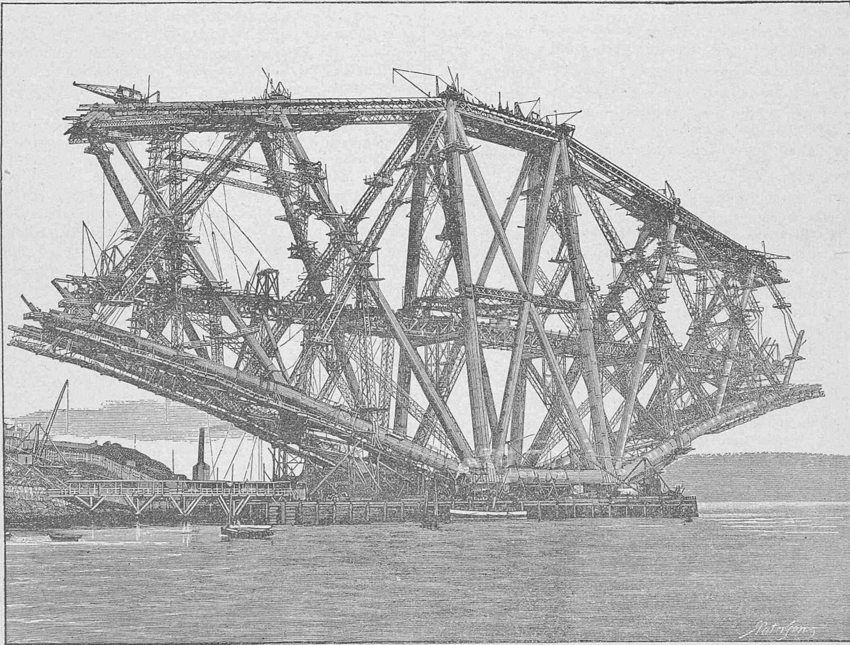
Die Forth-Brücke in Schottland. — Montirung des nördlichen Cantilevers.
