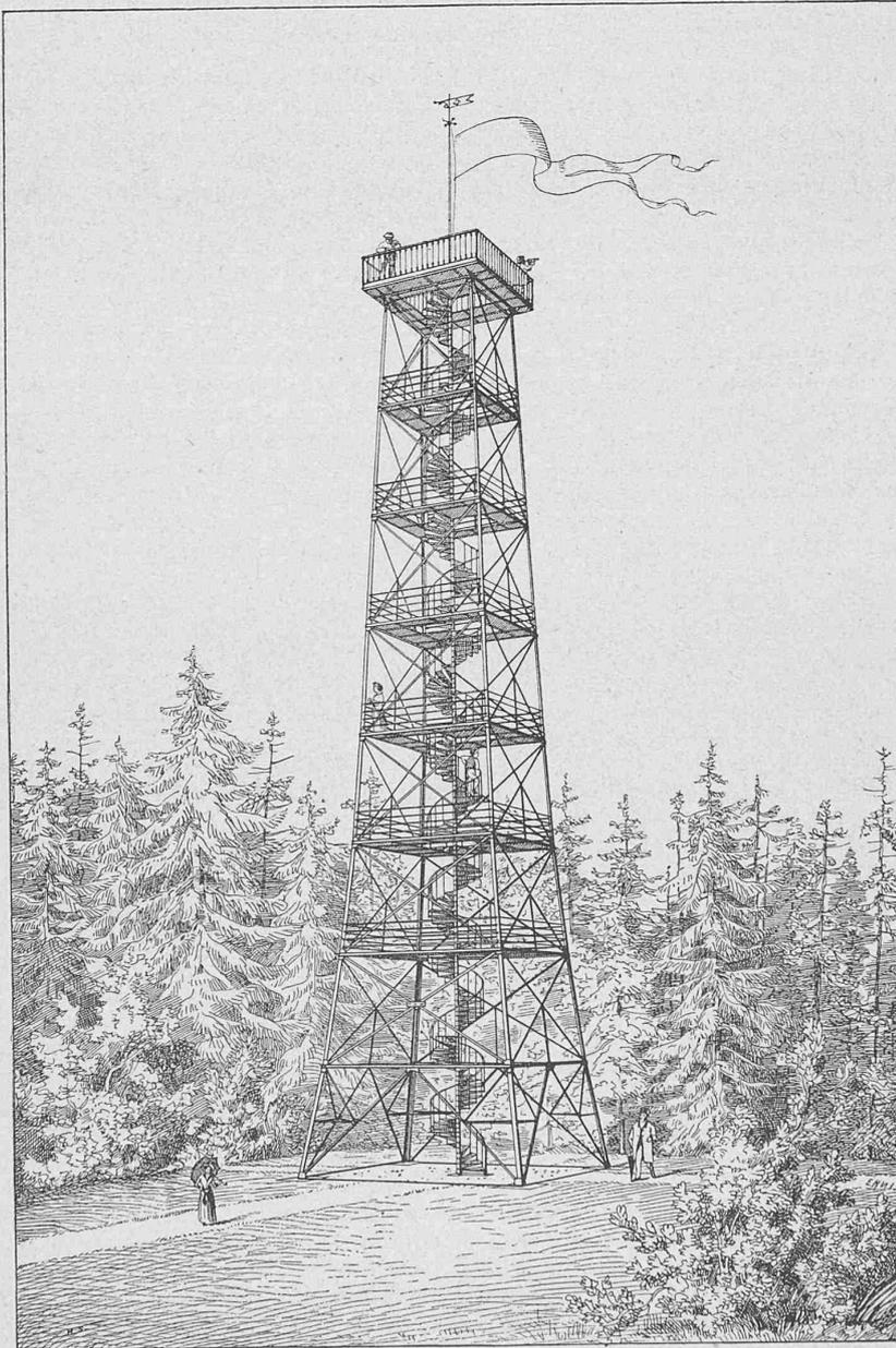
pfeilern, Leuchthürmen, Kaminen etc. angewendet wurde und sich zurückführen lässt auf die Begrenzungslinie eines Körpers von gleichem Widerstande. In Verticalentfernungen von 3,8 m befinden sich acht Plattformen, die mit Riffelblech abgedeckt sind und, mit Ausnahme der untersten, durch Geländer geschützt, dem Besteiger die nöthigen Ruhepunkte bieten. Dieselben dienen auch wesentlich dazu,
