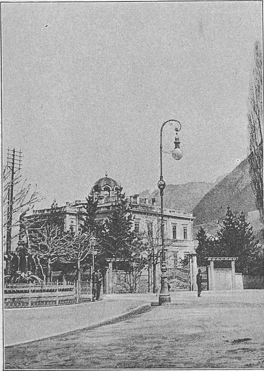
Fig. 4. Bogenlampen-Kandelaber mit Transformator.
