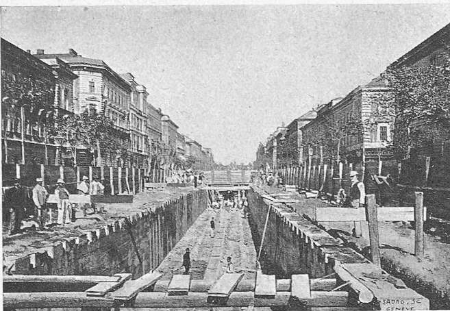
Fig. 2. Baustelle in der Andrassystrasse zwischen der Eötvösgasse und Csengerygasse nach Beendigung der Seitenmauern und der Sohle.
