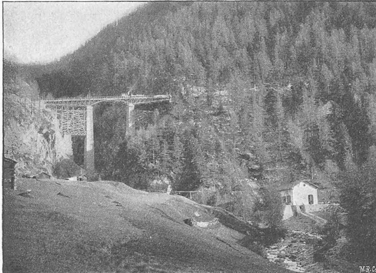
Fig. 6. Brücke über die Findelenbachschlucht. — Kraftstation.
